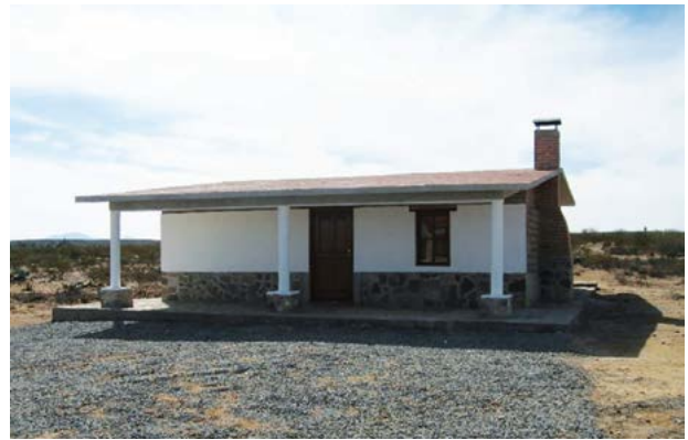
Figura 3. Cabaña construida dentro del ejido con subsidio federal para el hospedaje de cazadores durante la temporada de aprovechamiento.
