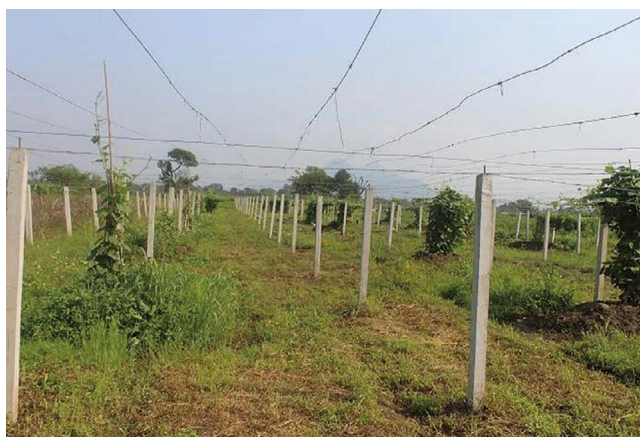
Figura 3. Estructura del tapanco sustentada sobre postes de concreto.
