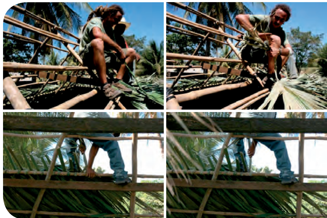
Figura 17. Colocación de las hojas de palma en la acción de techado de la palapa.
