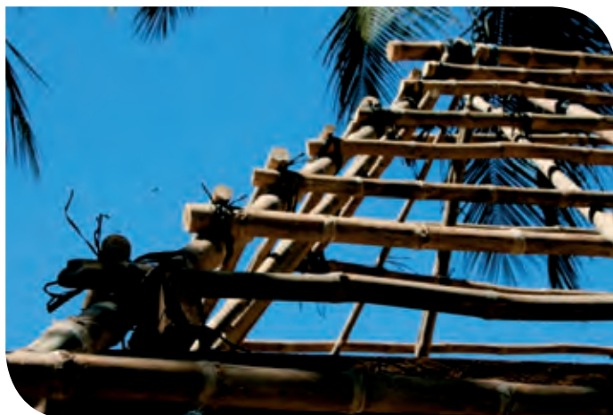
Figura 11. Detalle del amarre en los ‘esquineros’.
