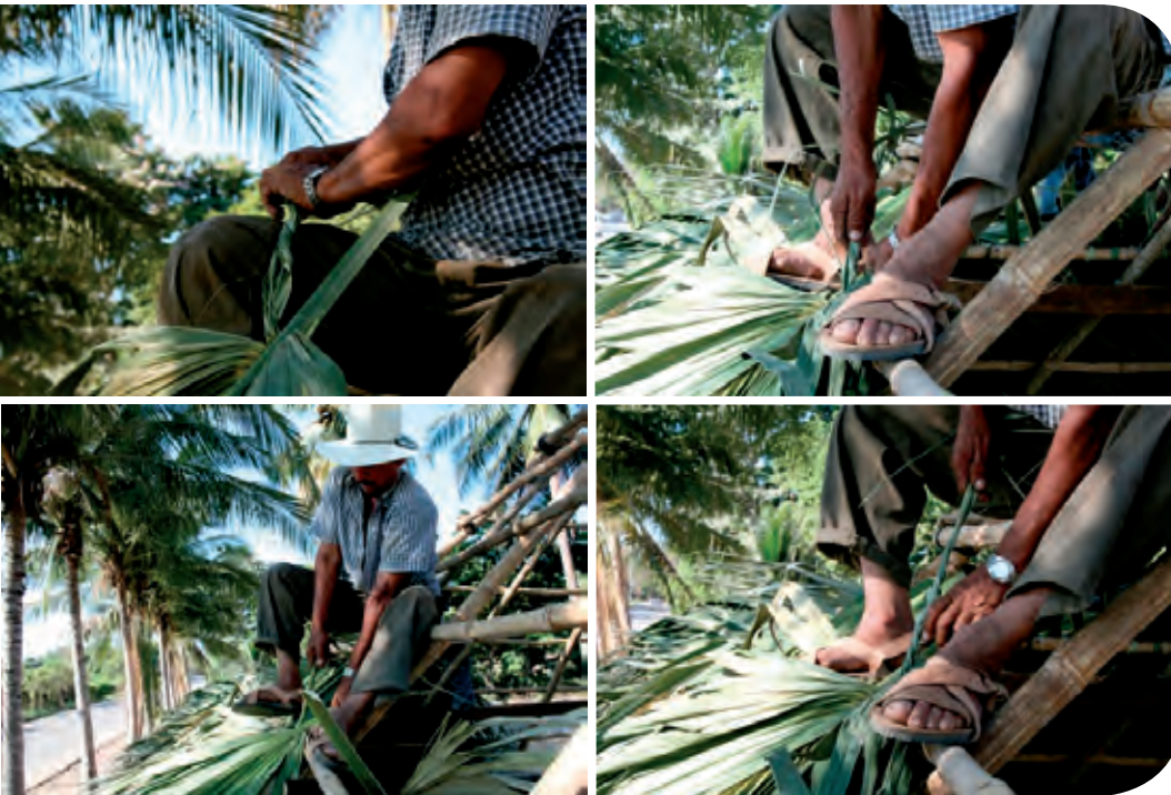
Figura 16. Secuencia de colocación de la hoja de palma ( Sabal mexicana ).
