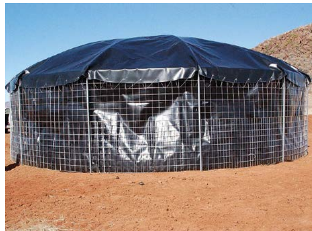
Figura 3. Fuente de agua (geomembrana) instalada en zona de berrendo (Fotografía Archivo Profauna).
