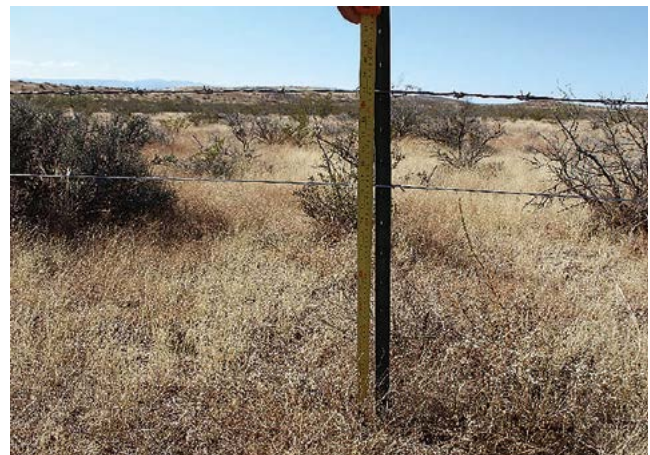
Figura 5. Alambre liso instalado para el libre paso de berrendos (Fotografía Archivo Profauna).
